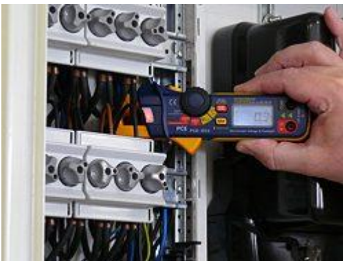
Comprovador de tensão a medir num quadro elétrico.
