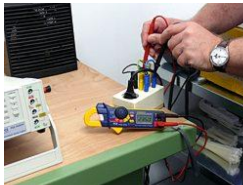
Comprovador de tensão a medir num posto de trabalho.
